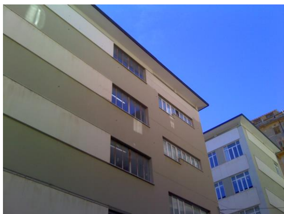
Figura 1 – Rilievo termografico del prospetto Nord
